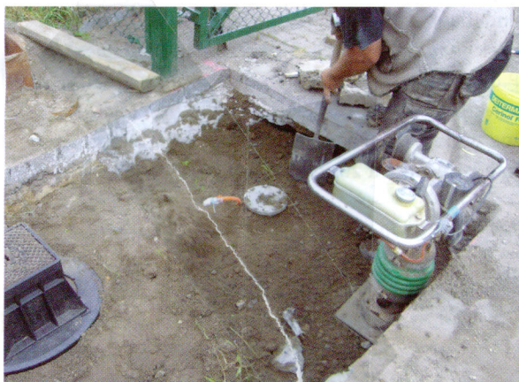
Einbau 3S 500 D unter einer Straßenkappe nach DIN 3528.
